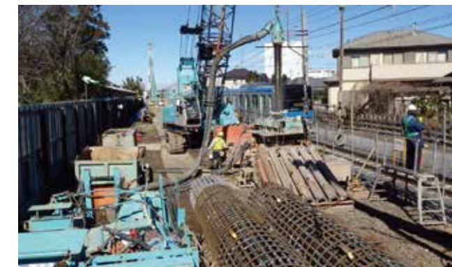
⑥野田市駅から梅郷寄りにかけて、高架橋の基礎工事を実施しています。
