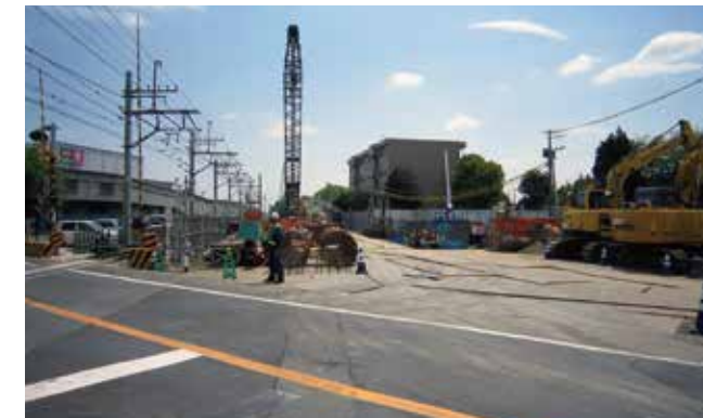
⑥野田市駅付近も順次、高架橋の建設を進めています。
